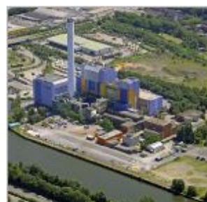
Die GMVA Oberhausen ist ein Public-Private-Partnership-Projekt der Städte Oberhausen und Duisburg mit dem Kreislaufwirtschaftsunternehmen REMONDIS
