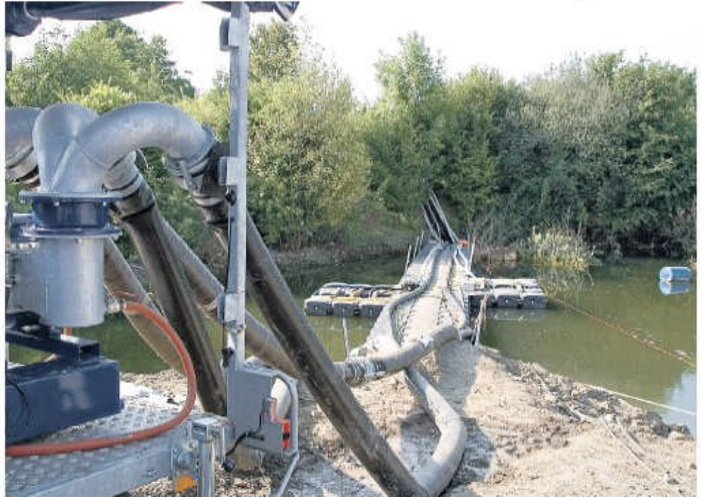
Mit leistungsstarken Pumpen rückte das THW an.
